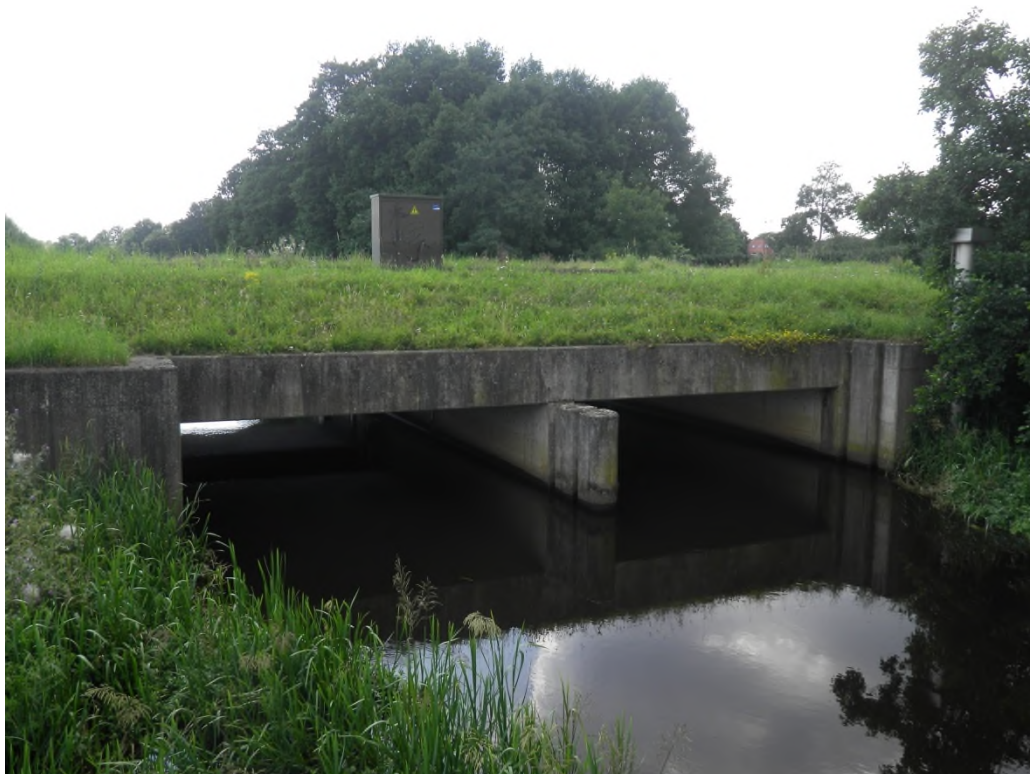
Figuur 4-4: Dijkvak 2, de Hammermolenstuw.
