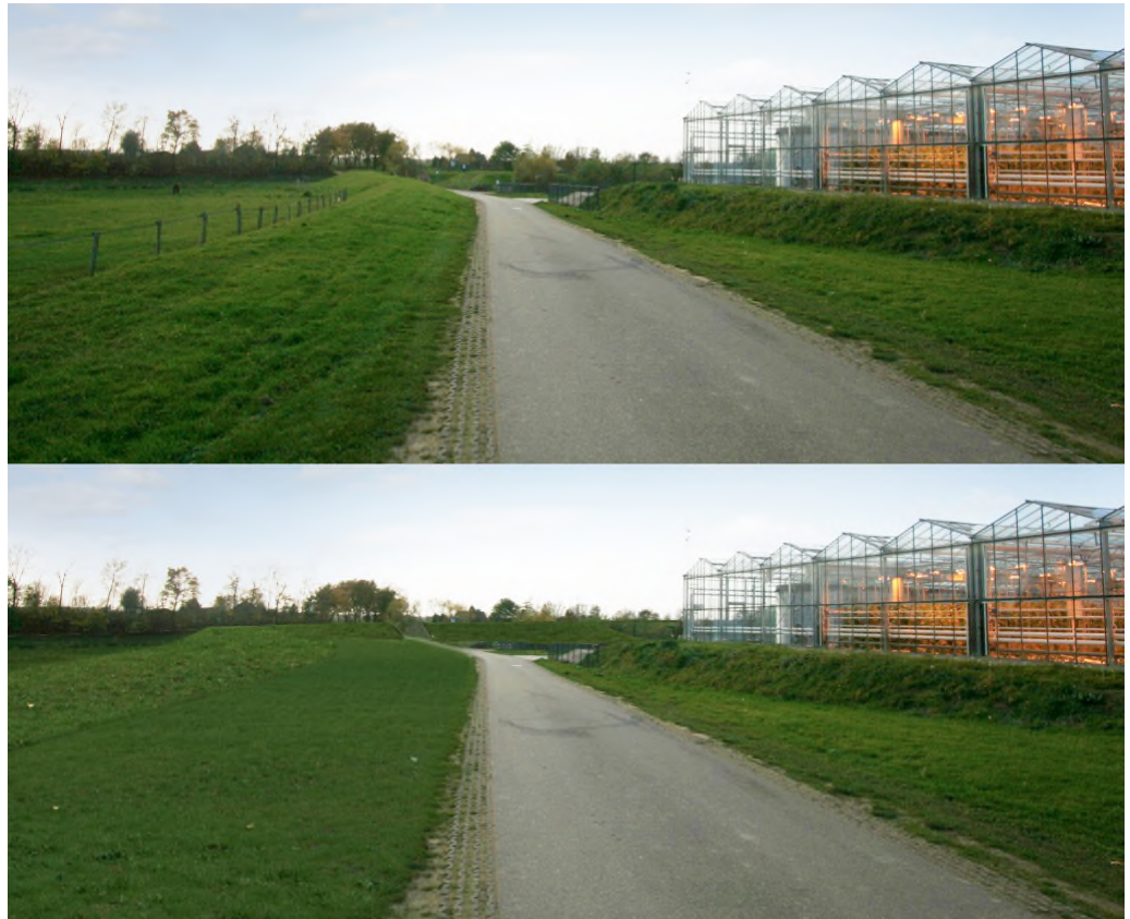
Figuur 5-8 Visualisatie van het dijkontwerp Neer op Molenstraat ter hoogte van de Winkelmolenstuw. De bovenste foto is de huidige situatie, in de onderste foto is het dijkontwerp ingetekend. De oude kering die nu nog op de onderste foto staat zal worden afgegraven.
