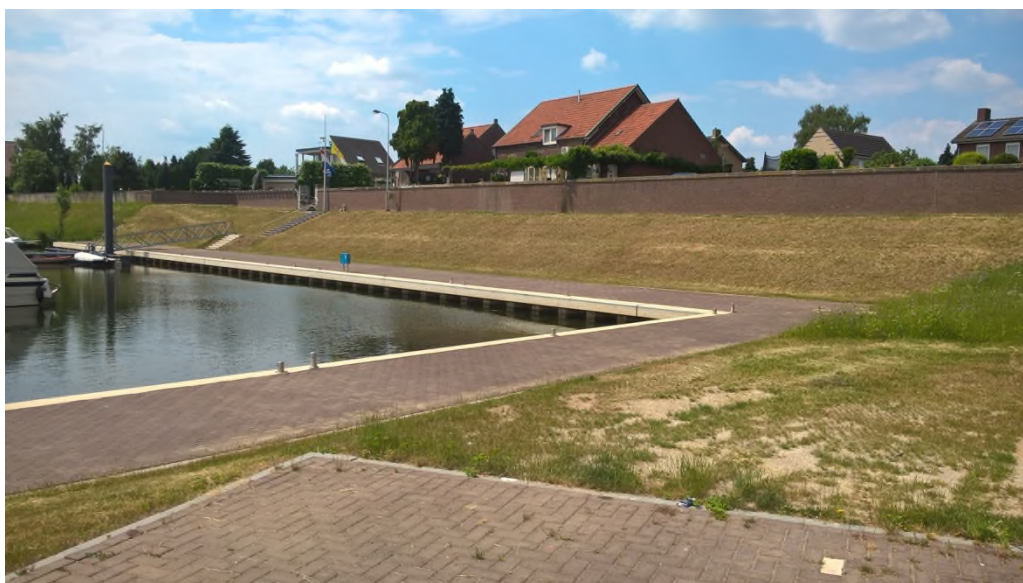
Figuur 4-22: Dijkvak 10c; de huidige keermuur gezien van de buitendijkse zijde. Bij het trappetje de coupure Hanssum.
