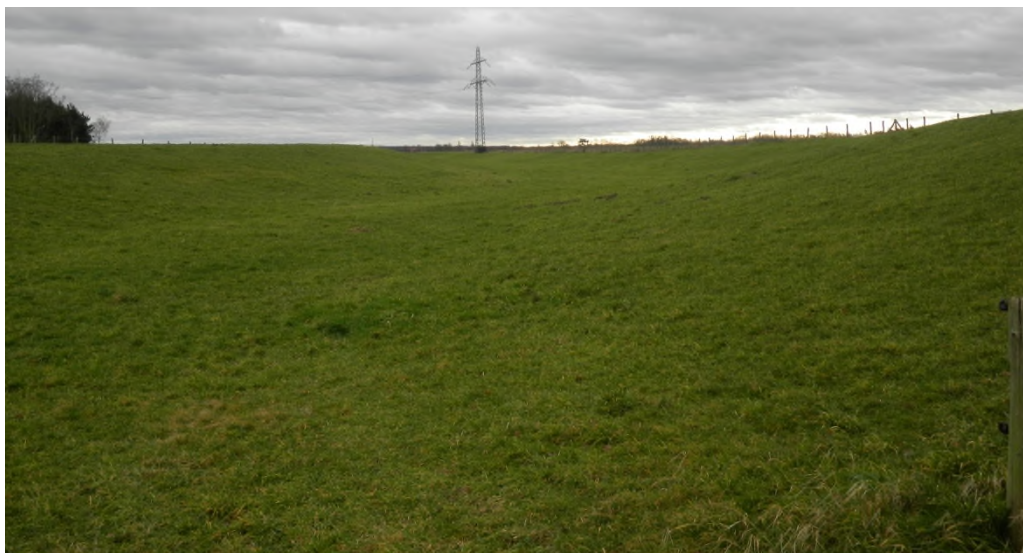
Figuur 4-10: Dijkvak 5; De bypass van de Neerbeek bij dijkvak 5 gezien vanaf de Rohrstraat. Ook is de hoogspanningsmast zichtbaar. Fotorichting is zuidwaarts.
