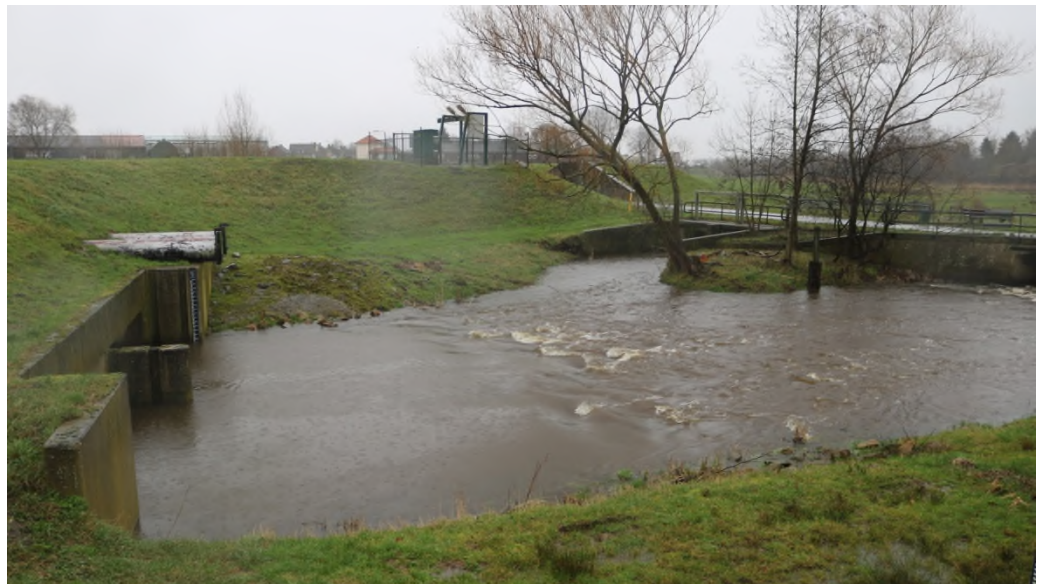
Figuur 4-14: Dijkvak 7, met links de Winkelmolenstuw met persleidingen met terugslagklep. Op de dijk is het pompstation van de rioolpersleiding zichtbaar, met ernaast de coupure van de Molenstraat. Aan de rechterzijde de brug over de Neerbeek.
