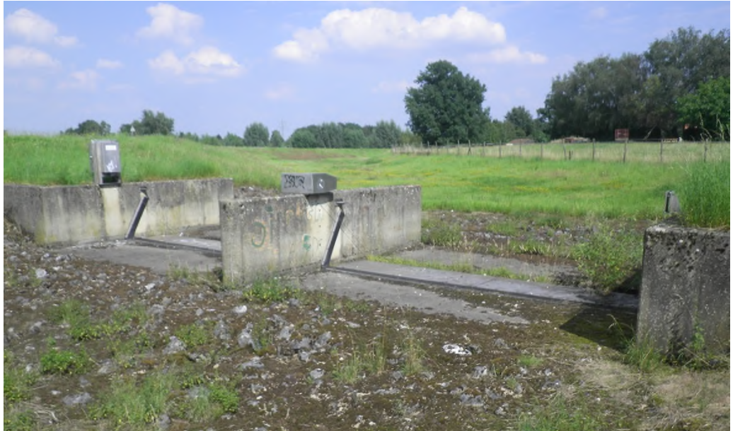
Figuur 4-7: Dijkvak 3; Kunstwerk aan de buitenzijde van de dijk, rand Neerbeek. Regelwerk van de bypass Neerbeek.
