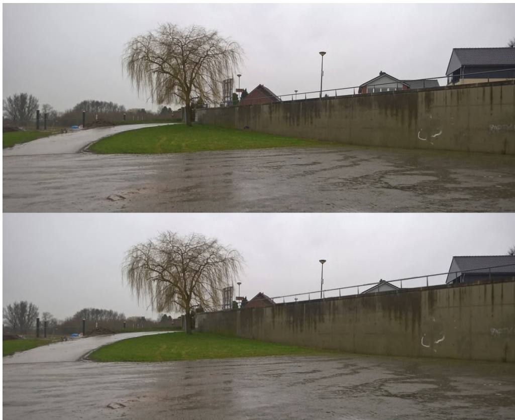
Figuur 5-9 Visualisatie van het dijkontwerp Neer, dijkvak 10. De bovenste foto is de huidige situatie, in de onderste foto is het dijkontwerp ingetekend.
