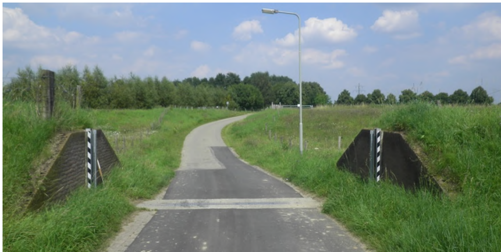
Figuur 4-9: Foto van de coupure in de Rohrstraat, die noodzakelijk is bij functioneren van de bypass. De coupure blijft gehandhaafd en de weg komt over de nieuwe kering heen te liggen. Fotorichting is noordwaarts.
