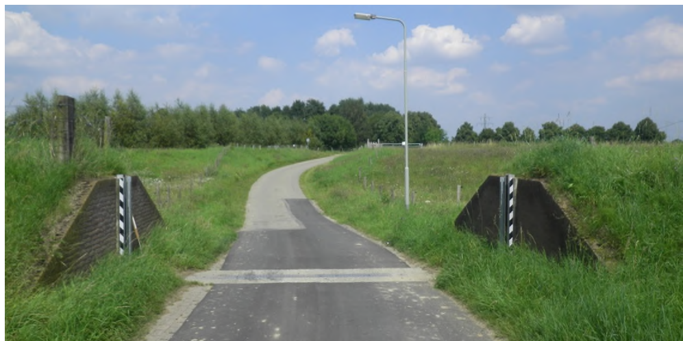
Figuur 4-9: Foto van de coupure in dijkvak 4, gezien vanaf de Rohrstraat. De coupure wordt gesaneerd en de weg komt over de nieuwe kering heen te liggen. Fotorichting is noordwaarts.
