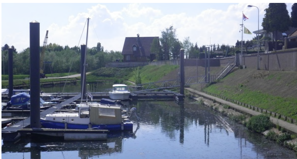
Figuur 4-22: Dijkvak 10c; de huidige keermuur gezien van de buitendijkse zijde. Bij het trappetje de coupure Hanssum. Fotorichting is zuid-westwaarts.
