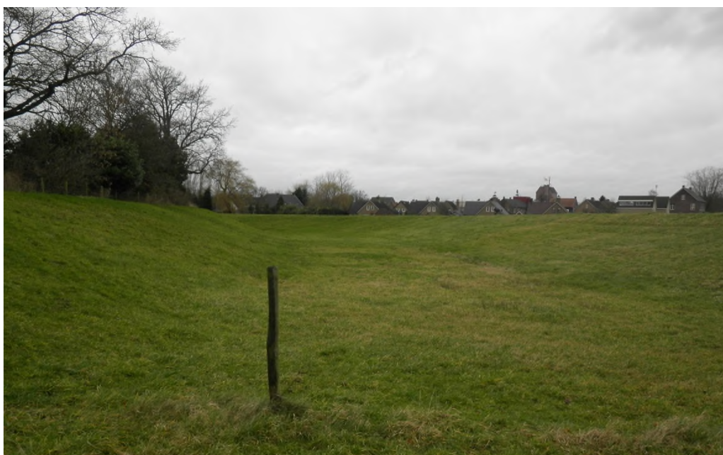
Figuur 4-6: Dijkvak 3 gezien vanuit de Rohrstraat (kering aan de rechterzijde). Het groene vlak is de bypass van de Neerbeek (groene rivier) die aan de buitenzijde van de dijk ligt.
