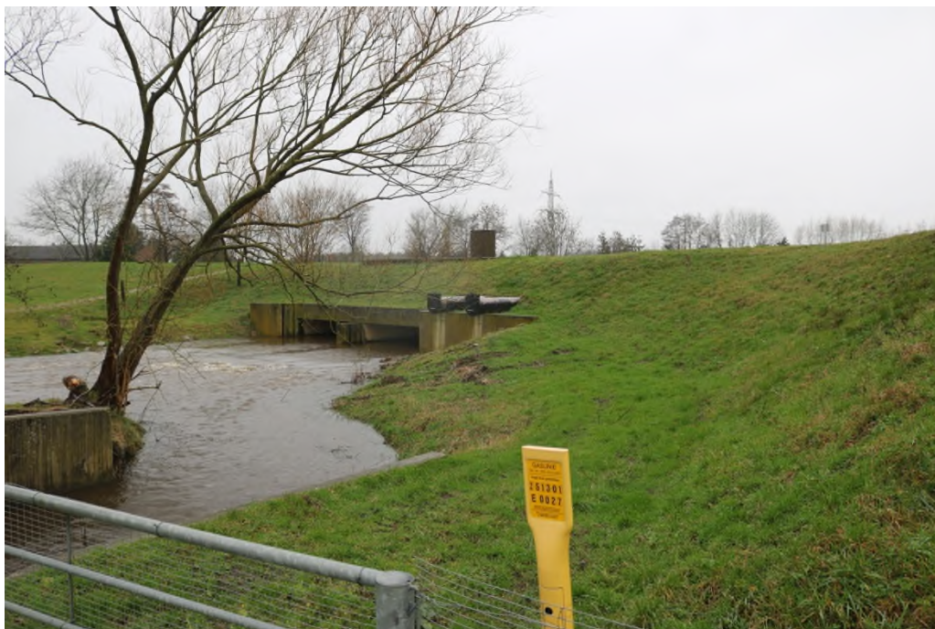
Figuur 4-16: Dijkvak 7; De Winkelmolenstuw gezien vanaf de Molenstraat. Op de voorgrond een paaltje dat aangeeft dat daar een leiding ligt van de Gasunie.
