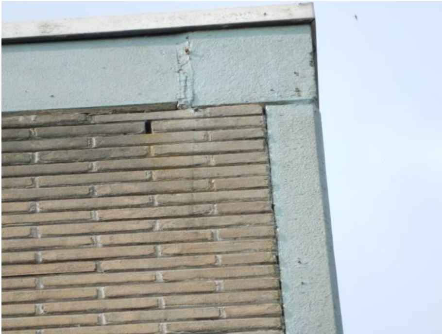
Figuur 3. Huidige situatie. De open stootvoegen, bieden toegang tot de spouwmuur en bevinden zich vlakbij de dakrand.
