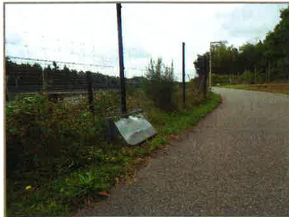
Klepluik, vanuit talud A28 doorgaanbaar, andersom niet
