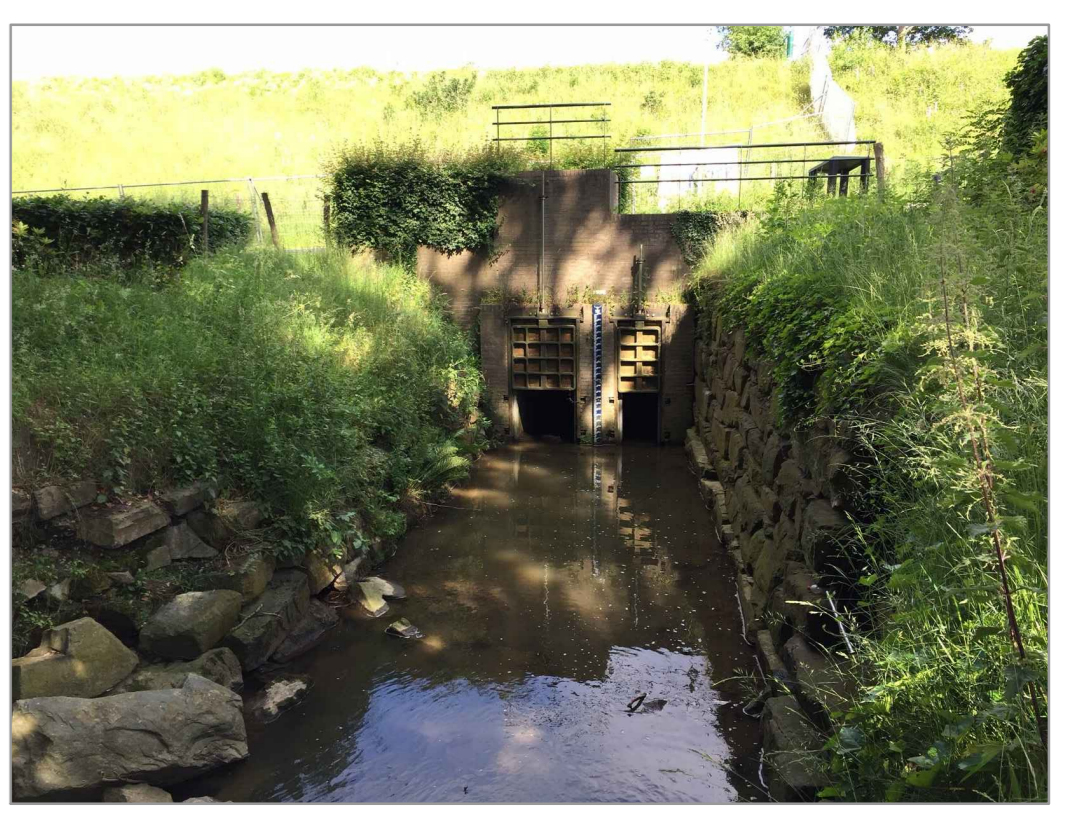
FOTO 3: AANZICHT 5B HUIDIGE SPINDELSCHUIVEN
