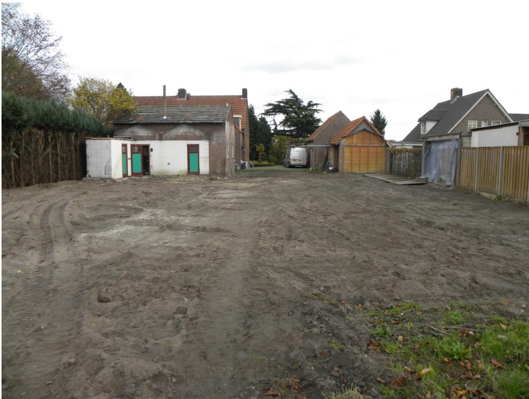
Foto's bestaande situatie
