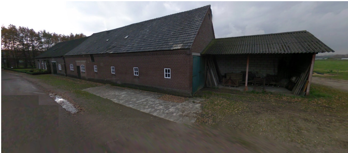
Figuur 5: bestaande agrarische bedrijfswoning: linker deel om te zetten in plattelandswoning
