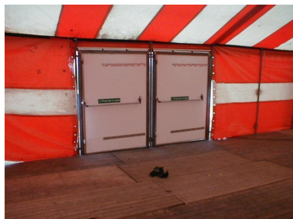
Voorbeeld hoe in een tent met zeildoekwanden ook een goede nooduitgang gemaakt kan worden
