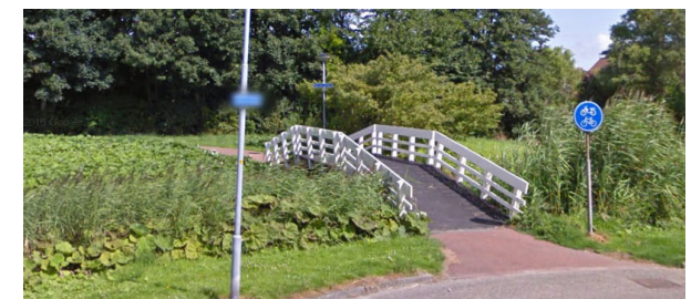
Reeds gerealiseerde bruggen, type C1 en C2
