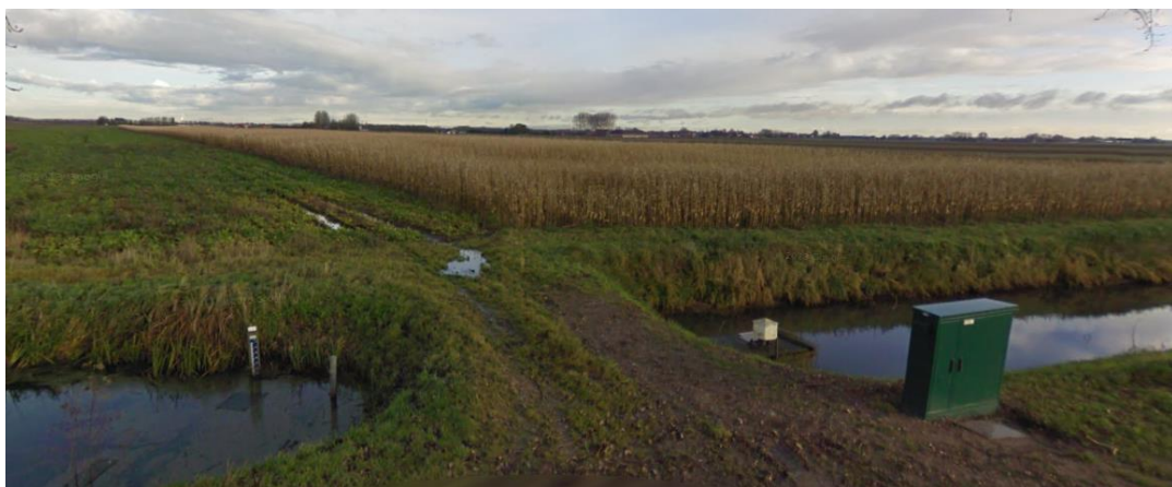
Afbeelding 5: het gemaal aan de Schenkeldijk te Nieuwendijk (bron: Google Maps).
