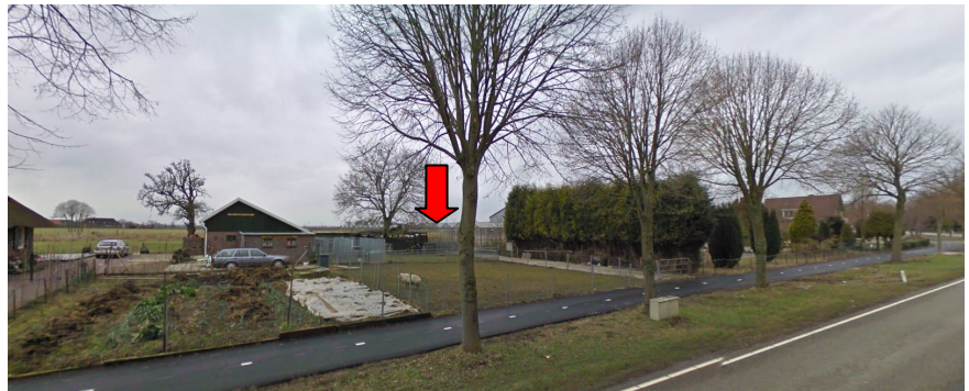
Figuur 5 Zijaanzicht (zuidzijde) bedrijfslocatie bij pijl (bron: GoogleStreetview)
