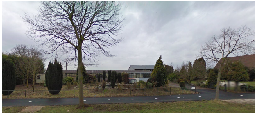
Figuur 6 Vooraanzicht (zuidzijde) bedrijfslocatie (bron: GoogleStreetview)
