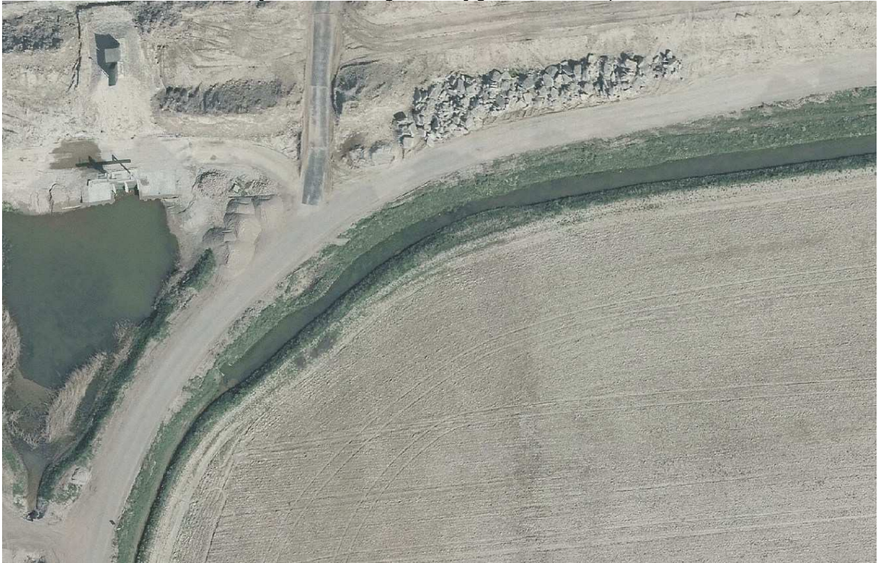
2015: luchtfoto bocht Noordelijke Ontwateringssloot bij gemaal Overdiepse Polder
