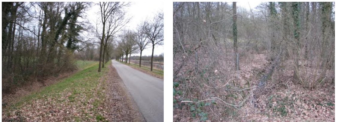
Figuur 3 - Rechts: westelijke kanaaldijk ter plaase van KM 3,61; Links: drooggevalen watergang
