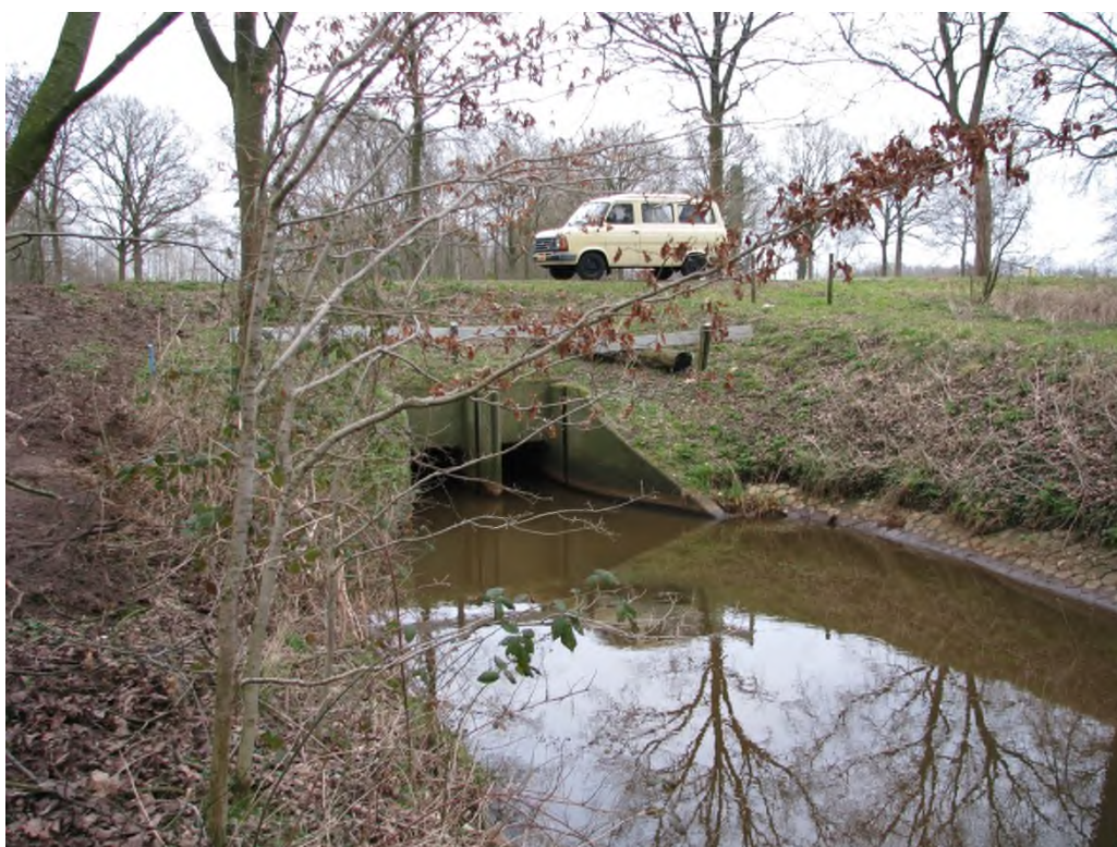
Figuur 4 - Uitstroom sifon aan westelijke kanaaldijk
