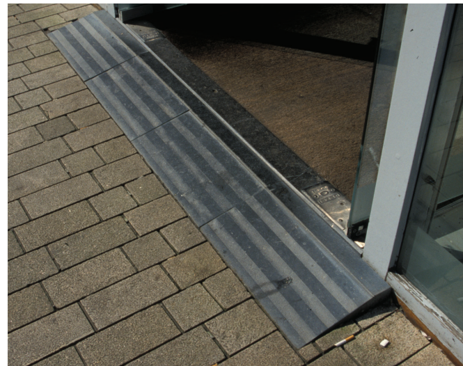
Opgang winkelentree in gevallen waar het hoogteverschil tussen stoep en entree niet met bestrating kan worden overbrugt.
