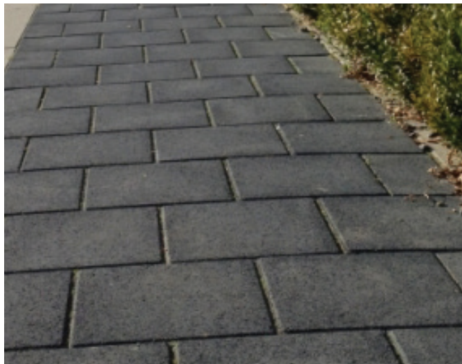
De stoep van het westelijke deel van de Willem de Zwijgerlaan uitgevoerd in betontegels.
