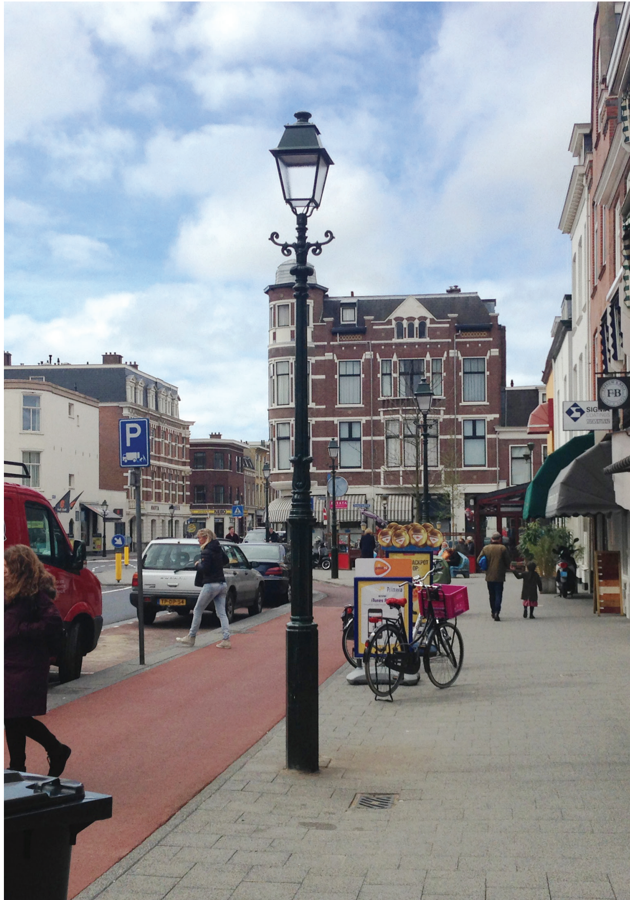
Haagse mast, lichtpunthoogte 3,5 m. Indien deze mast niet voldoende licht kan werpen op de rijbaan wordt er gekozen voor een model met hangende verlichting en additioneel Haagse masten.
