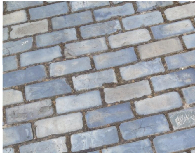
De middenberm van de Willem de Zwijgerlaan uitgevoerd in scoriabricks.
