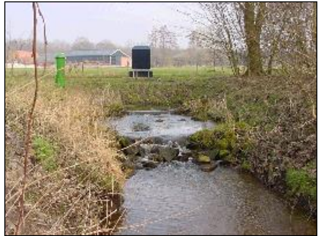
Afbeelding 2.7: drempel en waterinlaatwerk Omvloed
