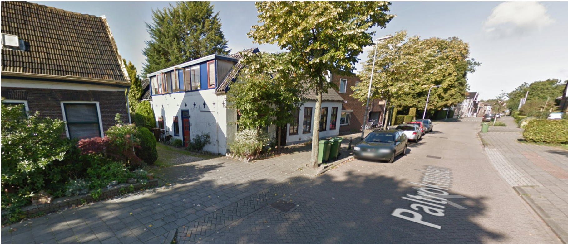
voorgevel bestaande bebouwing vanaf Paltrokmolen
