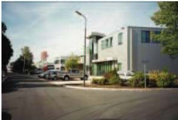
Entree kantoordeelte van bedrijf aan de Röntgenweg
