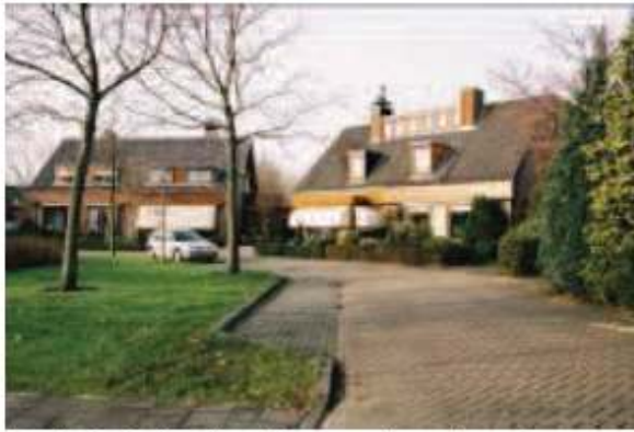
Opvallende dakkapellen bij twee onder-een-kapwoningen aan de Beethovenvlaan
