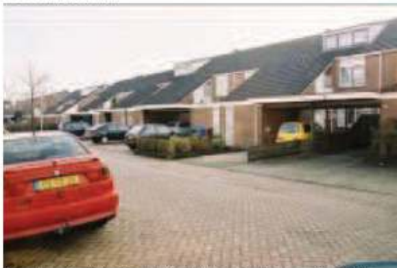
Doorlopende daken boven bergingen aan de voorzijde (Wilde Zwaan)
