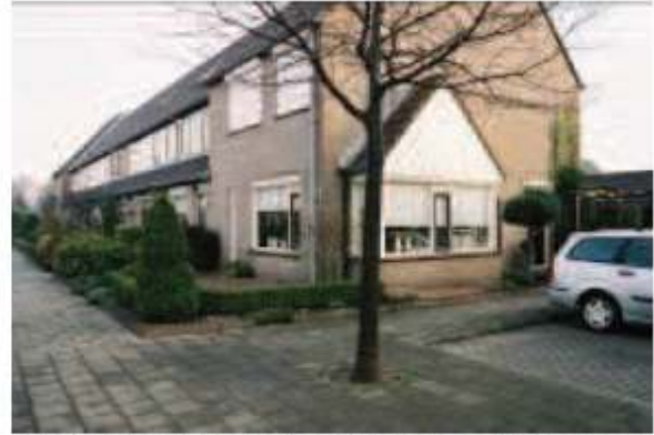
Nieuwbouw met bijzondere hoekwoningen aan de Veenestraat
