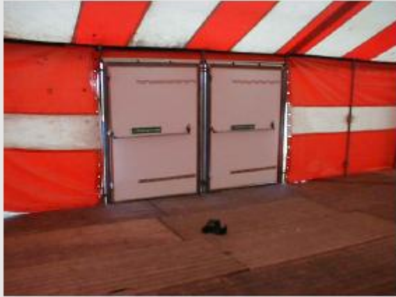
Voorbeeld hoe in een tent met zeildoekenwanden ook een goede nooduitgang gemaakt kan worden
