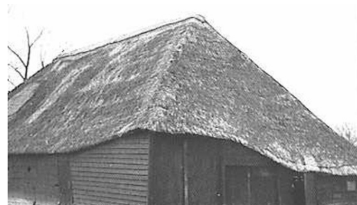
Afbeelding 3 Zij- en kopgevel Vlaamsche schuur Liesboslaan 32
