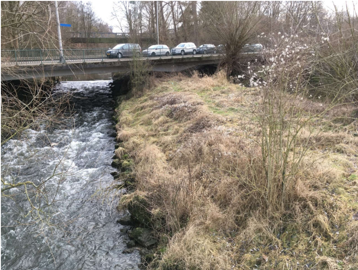
Figuur 3: Huidige situatie stroomaf van bodemval- zeer hoge stroomsnelheid
