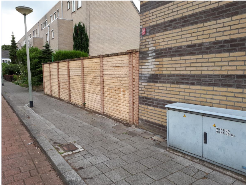
Huidige situatie Jean Monnetring 112 (2.00 Meter)
