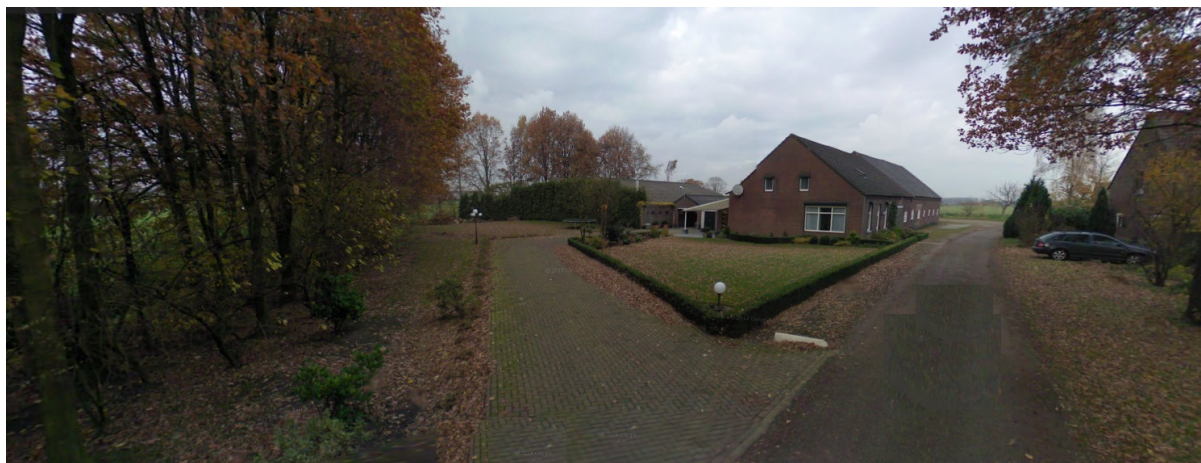
Figuur 6: bestaande agrarische bedrijfswoning
