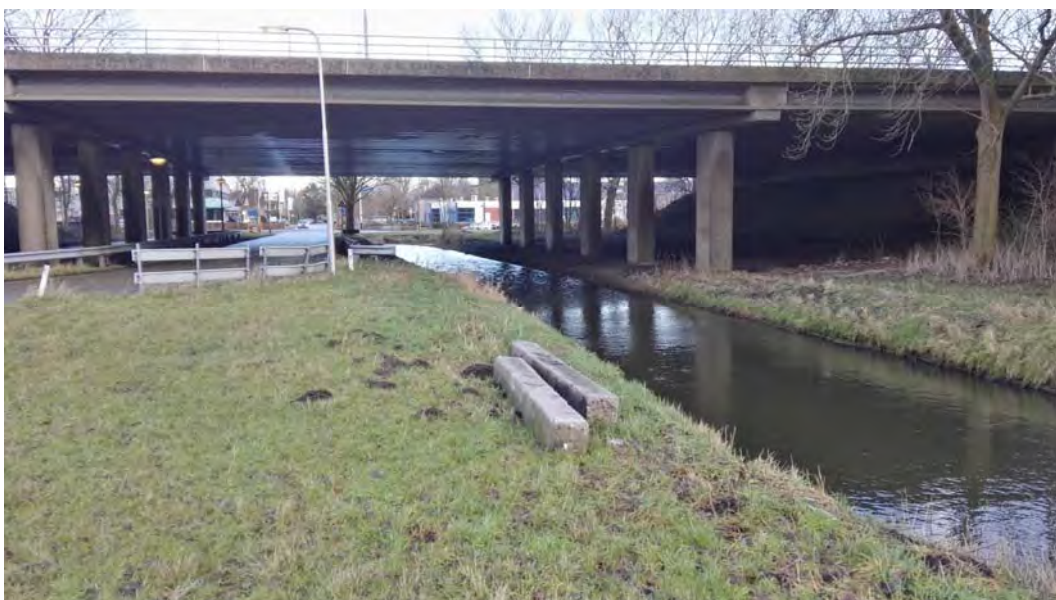
Figuur 4 overzicht uittredepunt HDD 2 (Polderweg)
