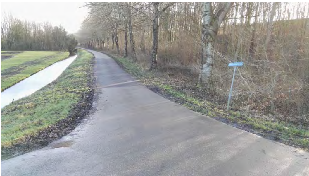
Figuur 14 Holendrechteweg (zicht op intreidelocatie)
