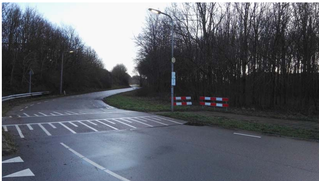
Figuur 1 overzicht intredepunt HDD 1 (Roendehoep West - Polderweg)
