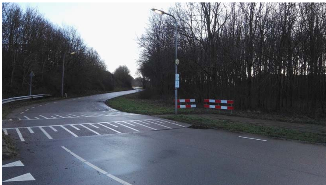
Figuur 1 overzicht intredepunt HDD 1 (Roendehoep West - Polderweg)
