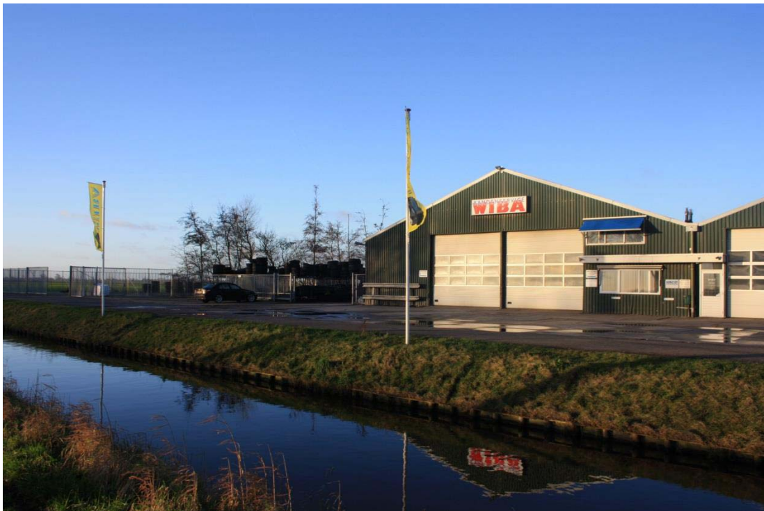
Afbeelding 1: Situatie (2014) waarbij de banden aan de achterzijde van de huidige schuren worden opgeslagen
