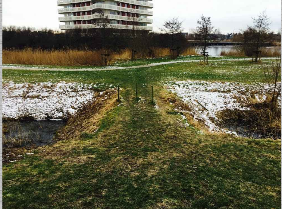
Dijk dichtzetten met bouwhekken tot aan waterlijn
