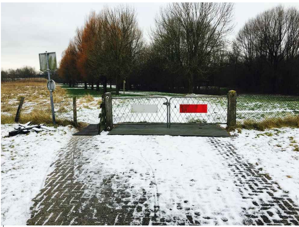
Voor afsluiting gebruik maken van bestaand hekwerk. Veroorster ten behoeve van fietsers en voetgangers fysiek afsluiten. Voortgaand schrikhekken plaatsen over gehele breedte van de toelijdende weg
