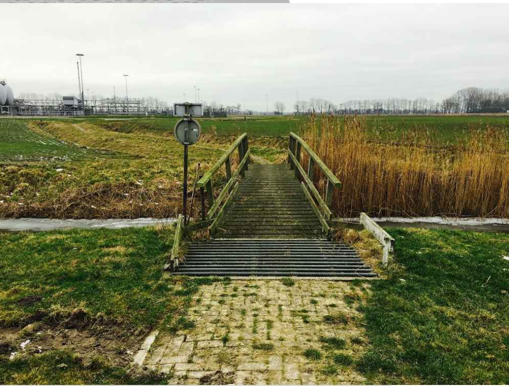
Brug fysiek dichtzetten. Plaatsen schrikhekken aan het begin van het toelijdende fiets-/ voetpad
