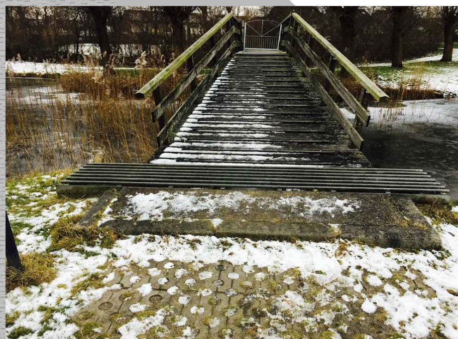
Hekwerk op brug fysiek dichtzetten met ketting en slot
