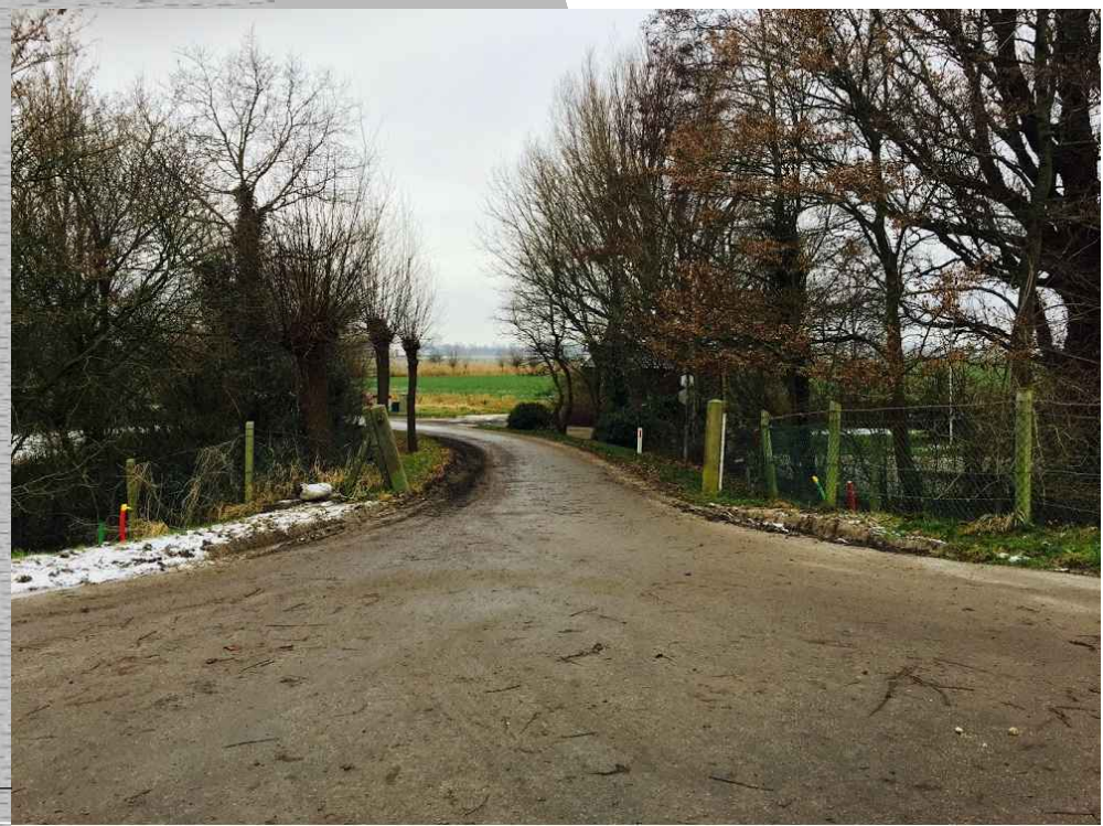
Dijkweg tussen beide betorpaten fysiek dichtzetten; (hoge bouwhekken bevestigd aan betonnen palen). In het midden 2 keer draaislot hek met ketting en slot (bij calamiteit). Toegangs schrikhekken voor bocht, na velden woningen sleutel draaislot hek v. sleutelkastje bij poort aanwezig. Pincode sleutelkastje wordt gecommuniceerd met betreffende partijen
