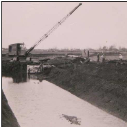
Figuur 4.1 Aanleg drinkwaterkanaal (1955)
