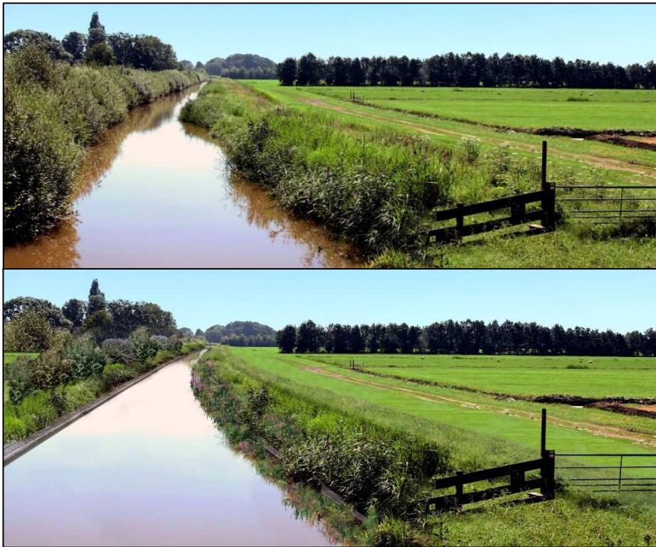
Figuur 5.2 Impressie dijk ophogen aan de zuidkant van de Scheendijk (situatie voor en na dijkverbetering)
