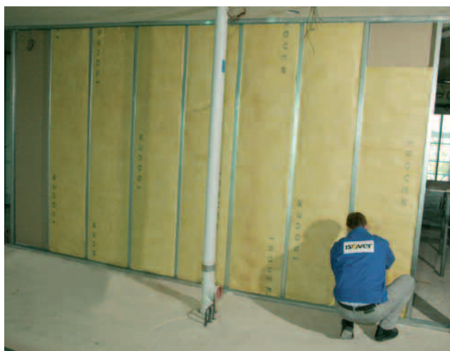
Hoeveelheid scheidingswand geïsoleerd met één rol Isover Soneroll 50 mm, 600 mm breed
