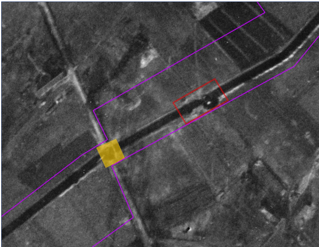
Figuur 14: Uitsnede georeferencierte luchtfoto met framenummer 2064, sortie 33-2077, daterende van 24 december 1944 met daarop zichtbaar beschadigde/vernieelde infrastructuur en waarschijnlijk een vernietigingslocatie.
