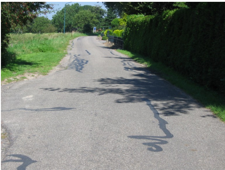
Hoge Maasdijk te Hedikhuizen, klein onderhoud asfalt
