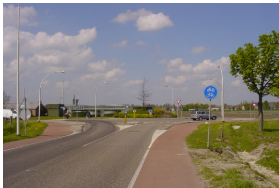
Rotonde Abt van Engelenlaan – Tuinbouwweg.
