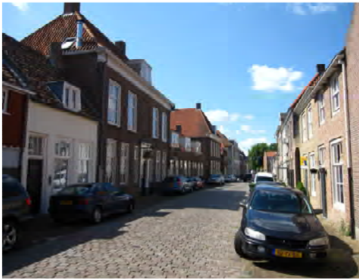
Putterstraat: gevelreclame binnen de structuur en detaillering van de gevel
