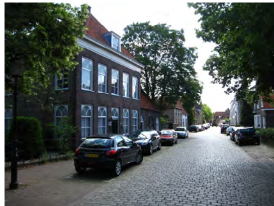
Burchtplein: diversiteit in gevelwanden in relatie met de ontstaansperiode
