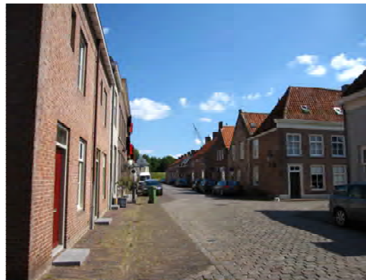
Putterstraat: zoveel mogelijk bestaande dakpannen hergebruiken
