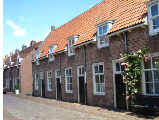
Lombartstraat: zorgvuldig vormgegeven dakkapellen die het karakteristieke dakvlak niet aantasten
