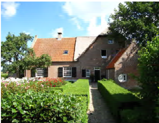
Grotestraat, Heesbeen: aanbouw ondergeschikt aan de hoofdvorm
