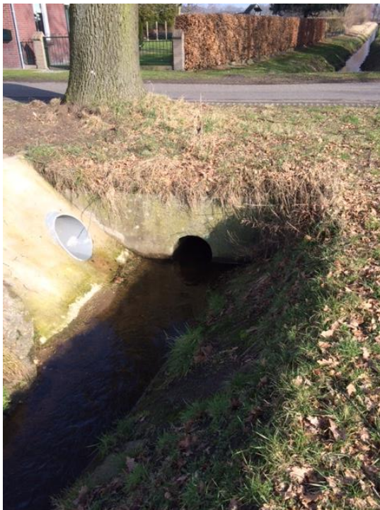
Te vervangen duiker en locatie aan te leggen noodstrook (februari 2017)
