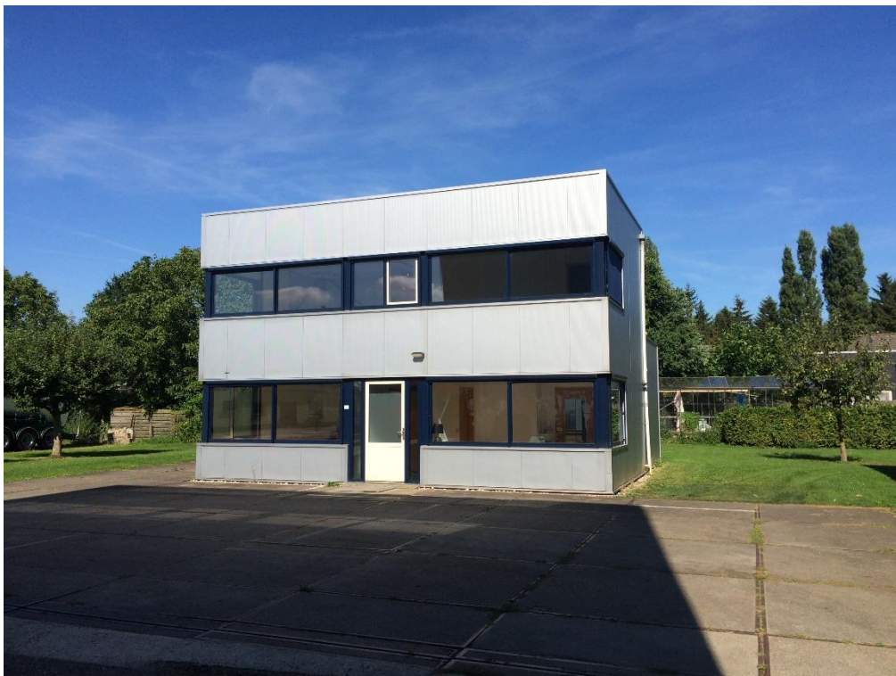
Bedrijfsbebouwing veevoederfabriek gezien vanaf centraal punt plangebied richting noorden
