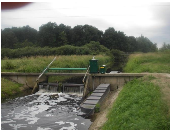
stuw, rechts: verspringende openingen in de vispassage
