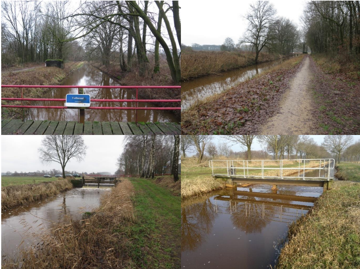
Figuur 2. Met de klok mee: foto genomen vanaf brug Schippersdijk, aan linkeroever is een kazemat te zien; stuw 107P1; stuw 107P2; stuw 107P3.
