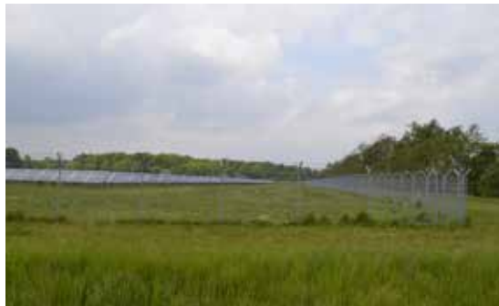
Het hekwerk staat op te grote afstand van de panelen ...
