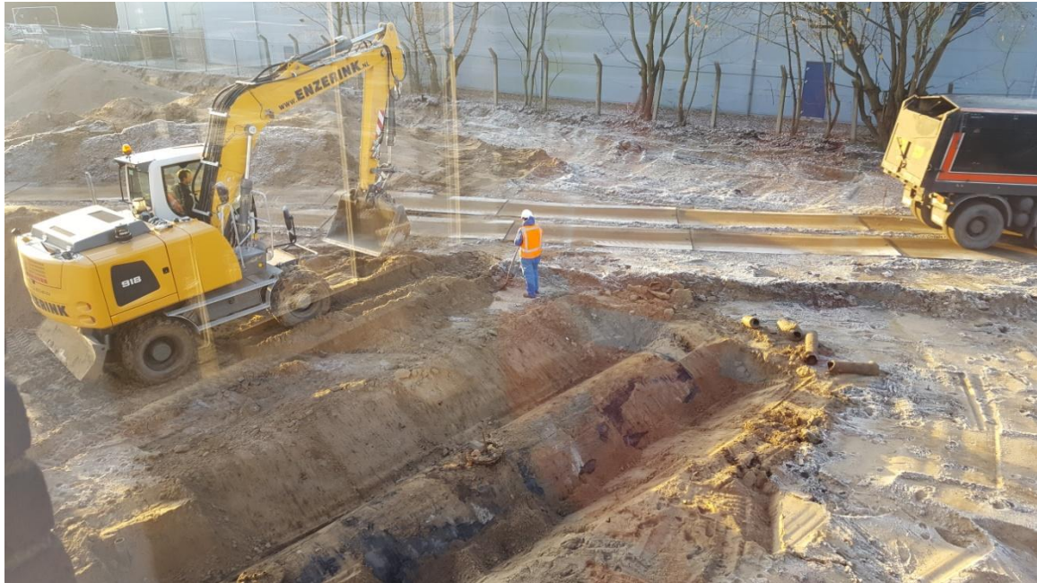
Afbeelding 4.5 Vrijgraven ondergrondse tank 30 m 3 (30 november 2016)
