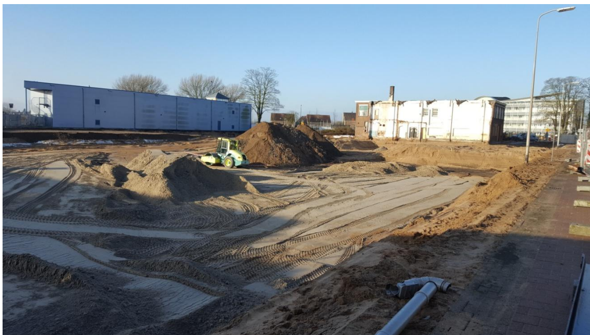
Afbeelding 4.8 Aanvulling met schone grond beneden 2 m-mv (10 januari 2017)
