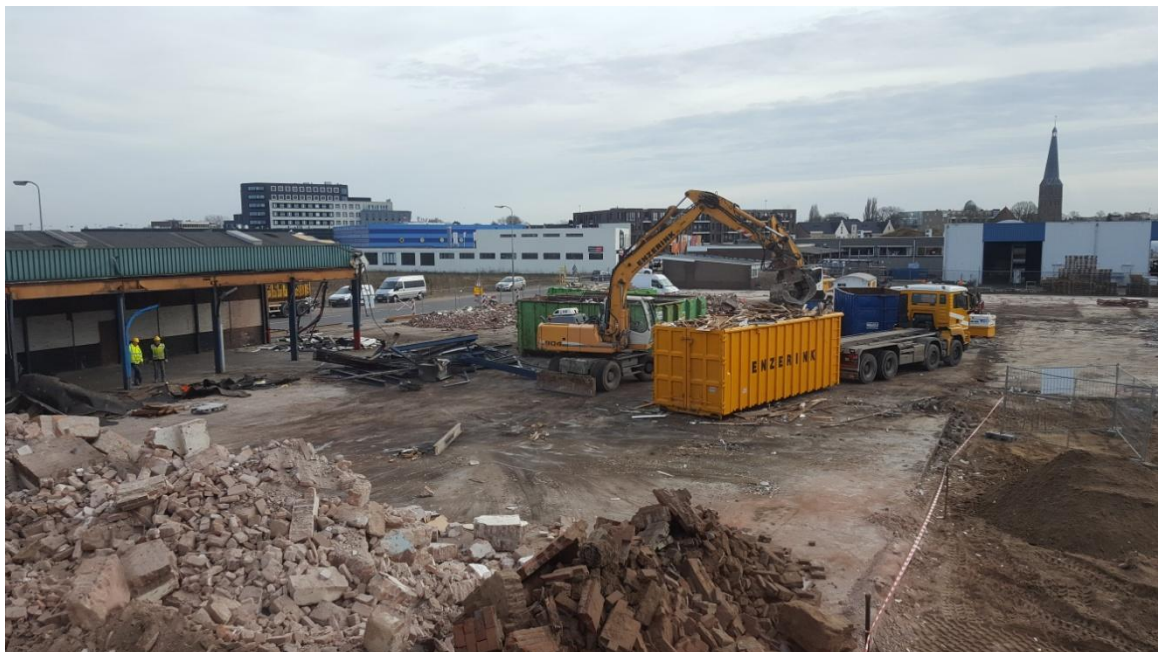
Afbeelding 4.3 Sloop bovengrondse opstallen (24 november 2016)
