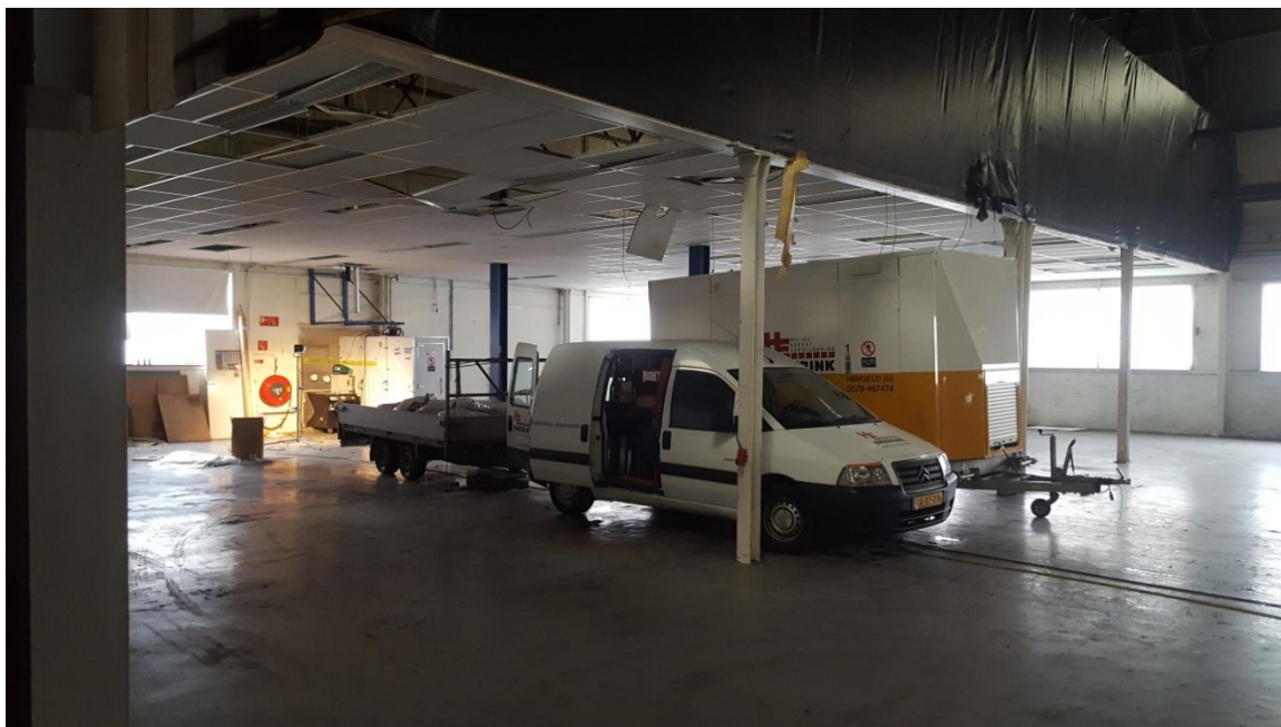
Afbeelding 4.1 Inpandige asbestsanering (19 oktober 2016)
