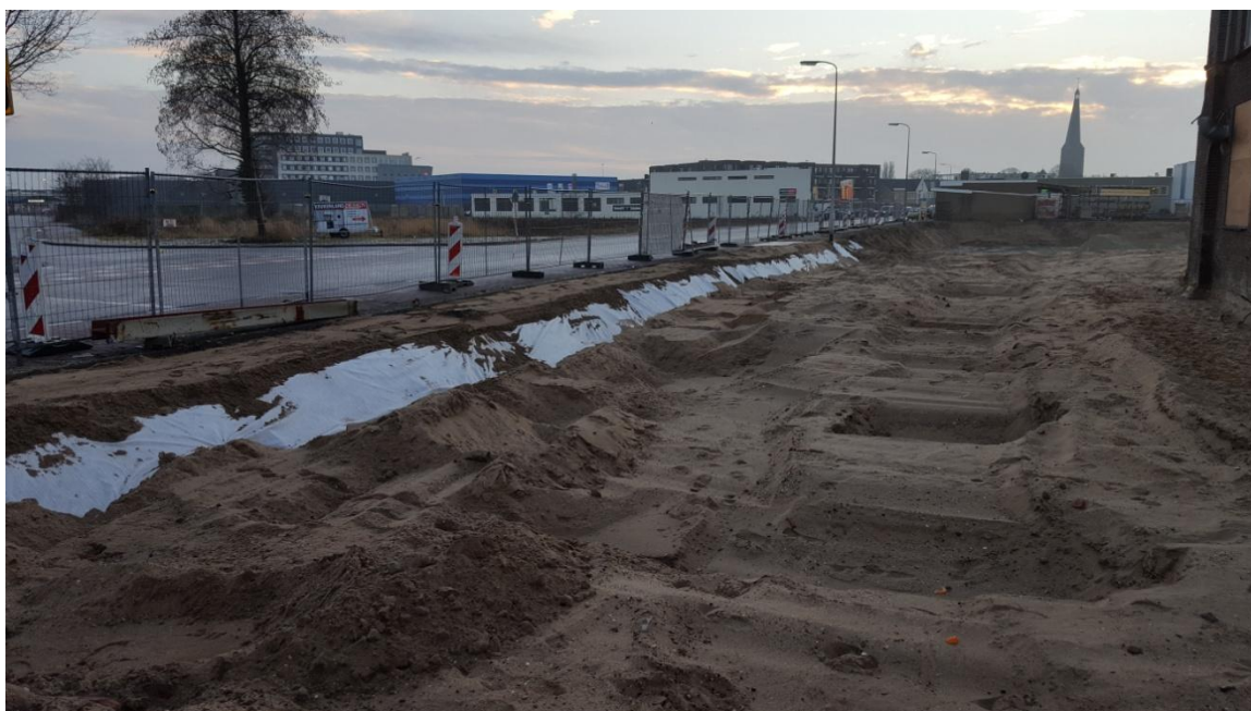
Afbeelding 4.9 Aanbrengen signaallaag op terreingrens (10 januari 2017)
