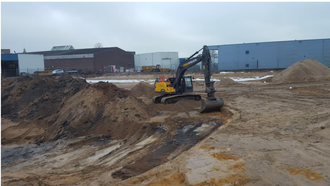
Afbeelding 4.7 Diepe ontgraving binnen ontgravingsvak C
