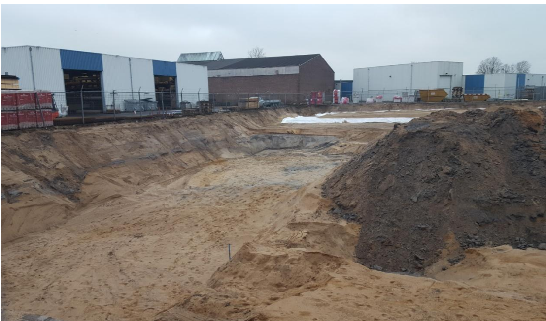
Afbeelding 4.11 Diepe ontgraving ontgravingsvak C richting oostelijke terreingrens (22 december 2016)
