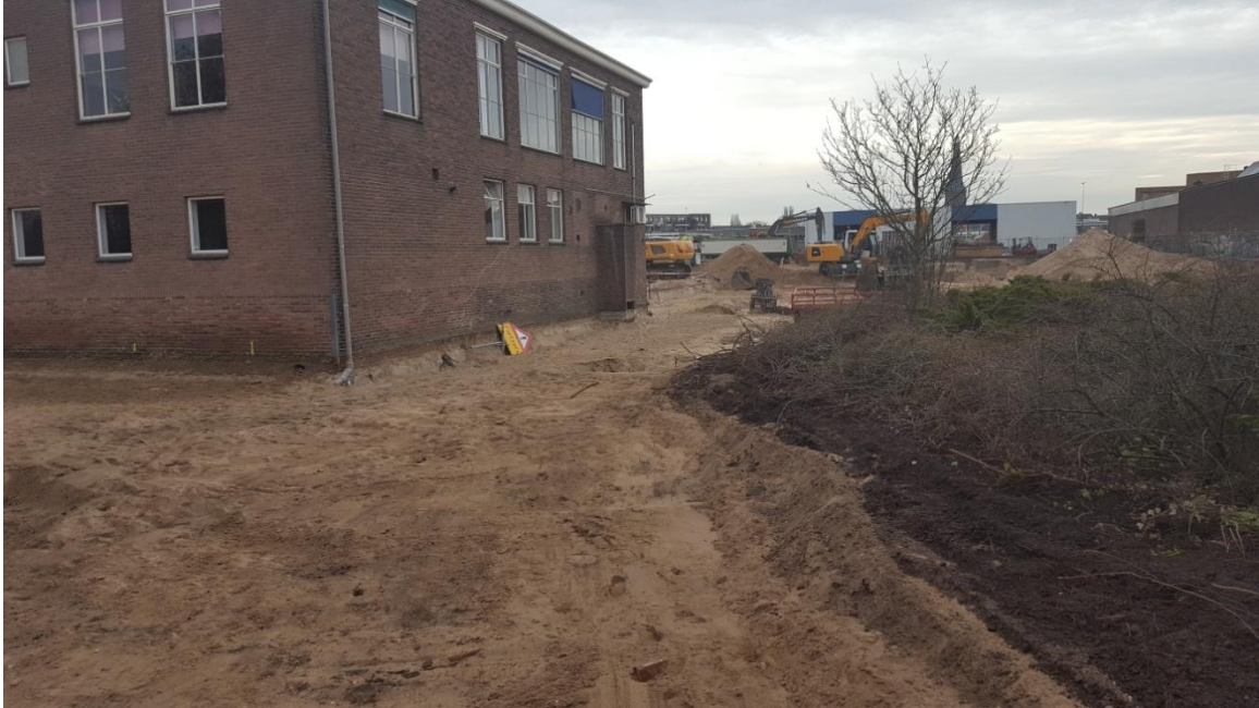
Afbeelding 4.6 Ontgraving bovengrond (7 december 2016)
