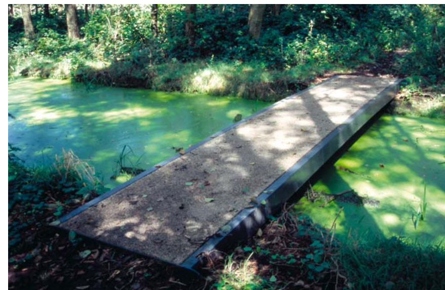
voetgangersbrug staal met dek compostiet (Haasnoot type HB 055)
