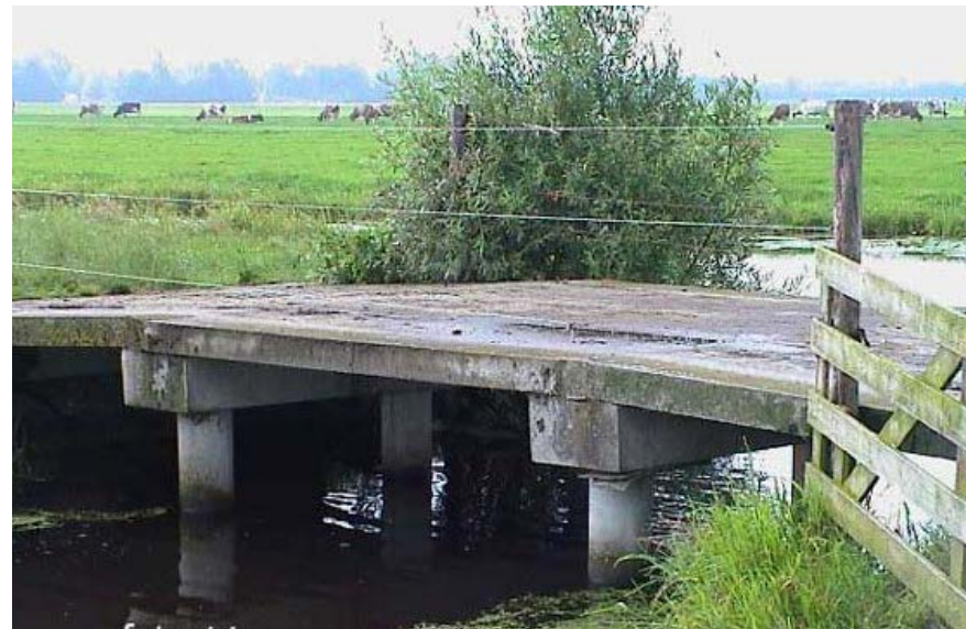
eenvoudige landbouwbrug in beton
