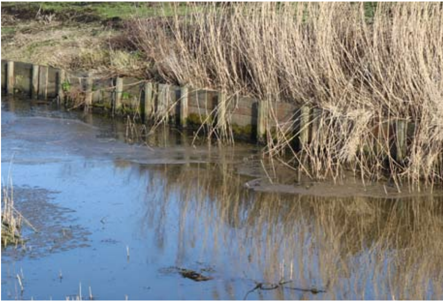
5.1 Bestaande oever fase 3, beschoeiingen worden verwijderd en oevers worden vergraven tot natuurvriendelijke oevers
