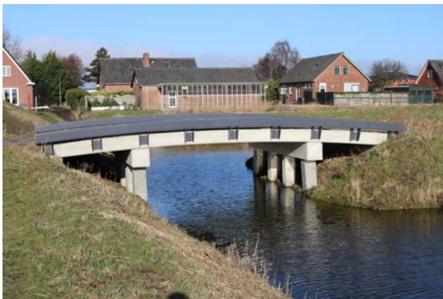
1.1 Bestaande betonbrug, aanzicht
