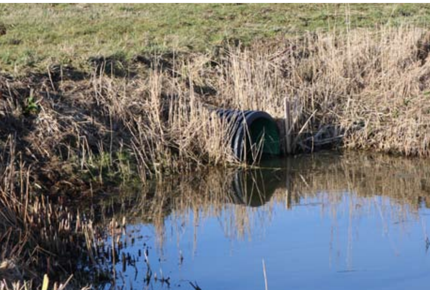
4.3 Bestaande dam met duiker
