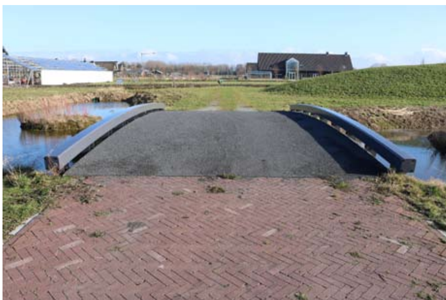
1.3 Bestaande betonbrug, dek met antraciet kleurige slijtlaag
