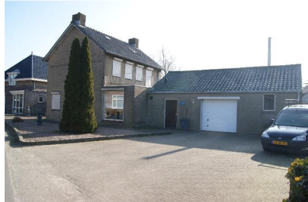
Bestaande woning Torenstraat 7 met garage
