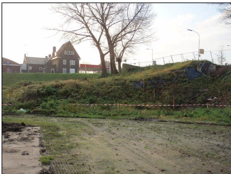
P2015-1977, Depot D1 Fabriekslaantje Tiel - asbest, foto F1 (15 december 2015)
