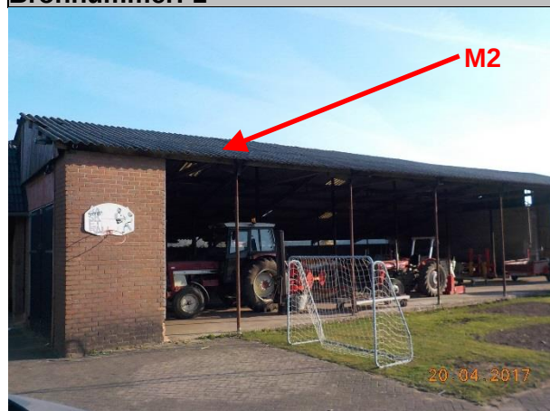
Golfplaten op dak van schuur 1.
