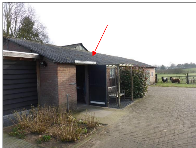
Foto 10: Schuur 2: Golfplaten dak (M03AA)
