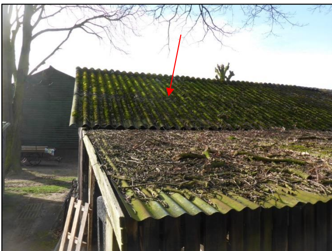
Foto 23: Schuur 4: Golfplaten dak (M05AA)
