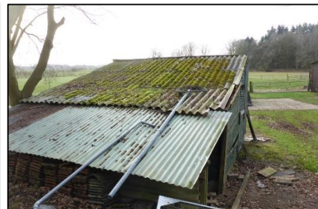
Schuur 5: Golfplaten dak (M06AA)
