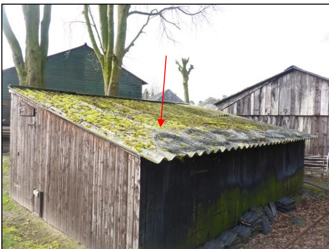
Foto 35: Schuur 6: Golfplaten dak (M07AA)
