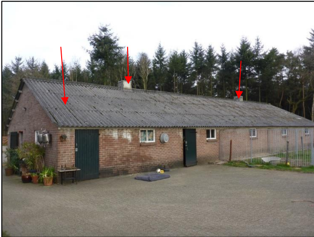
Foto 1: Schuur 1: Golfplaten dak (M02AA) & Ventilatiekokers (M01AZ)
