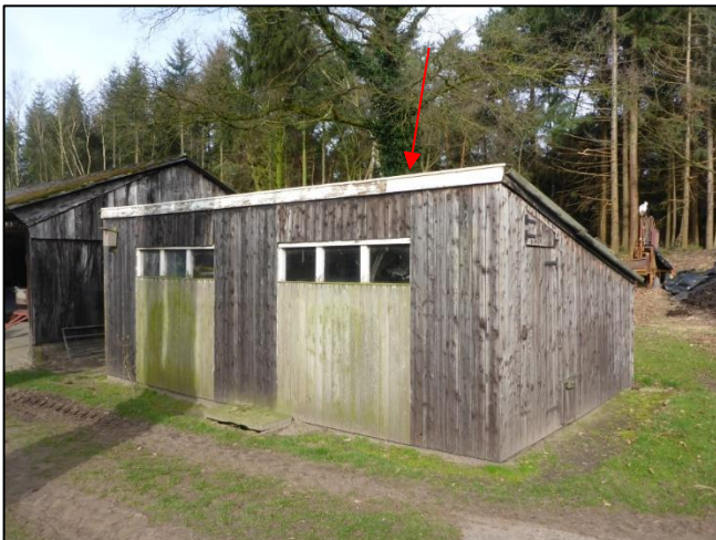
Foto 33: Schuur 6: Golfplaten dak (M07AA)
