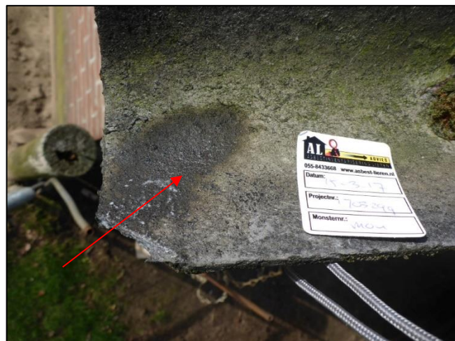
Foto 18: Schuur 3: Golfplaten dak (M04AA)
