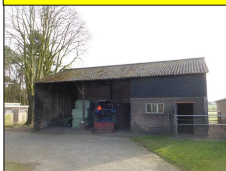
Schuur 3: Golfplaten dak (M04AA)
