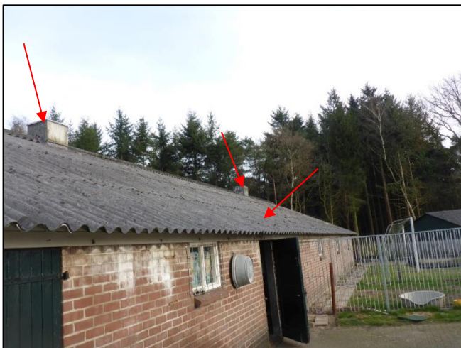
Foto 9: Schuur 1: Golfplaten dak (M02AA) & Ventilatiekokers (M01AZ)
