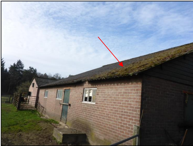
Foto 19: Schuur 3: Golfplaten dak (M04AA)
