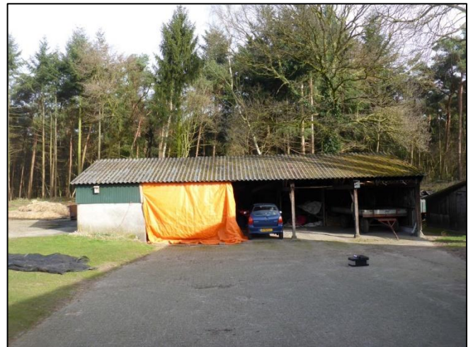
Foto 22: Schuur 4: Golfplaten dak (M05AA)
