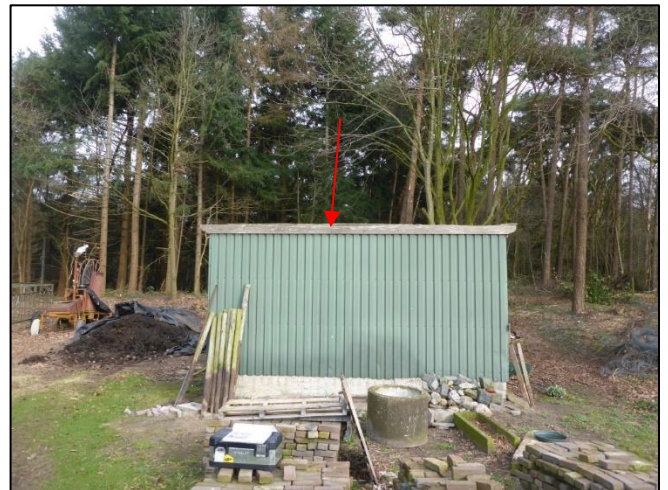
Foto 28: Schuur 5: Golfplaten dak (M06AA)
