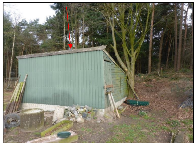
Foto 30: Schuur 5: Golfplaten dak (M06AA)
