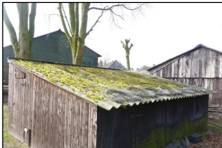
Schuur 6: Golfplaten dak (M07AA) Gedeelte blikken platen
