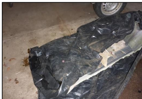
Schuur 1: Golfplaat (M02AZ)
