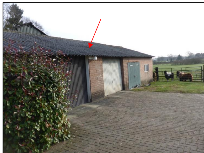
Foto 12: Schuur 2: Golfplaten dak (M03AA)
