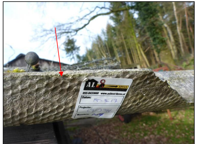
Foto 34: Schuur 6: Golfplaten dak (M07AA)
