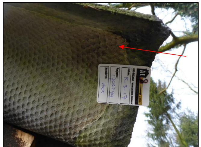
Foto 24: Schuur 4: Golfplaten dak (M05AA)
