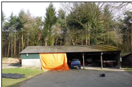
Schuur 4: Golfplaten dak (M05AA)
