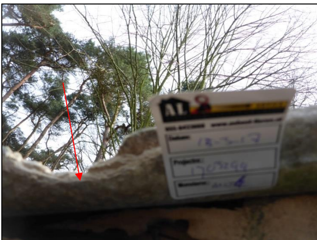
Foto 29: Schuur 5: Golfplaten dak (M06AA)
