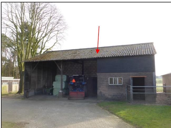
Foto 17: Schuur 3: Golfplaten dak (M04AA)
