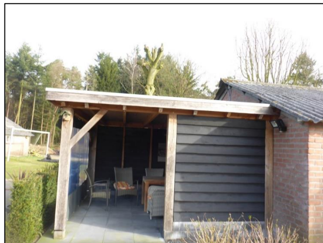
Foto 16: Aanbouw schuur 2 (Asbestvrij)
