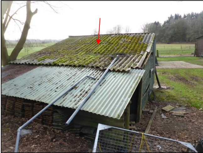
Foto 31: Schuur 5: Golfplaten dak (M06AA) Afdak (blikken platen)
