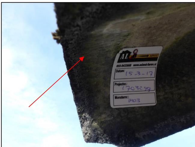
Foto 11: Schuur 2: Golfplaten dak (M03AA)
