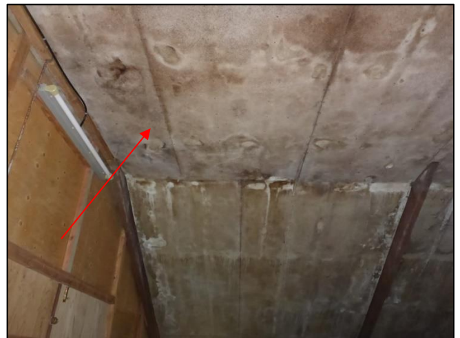
Foto 4: Schuur 1: Plafondbeplating (M01AA)
