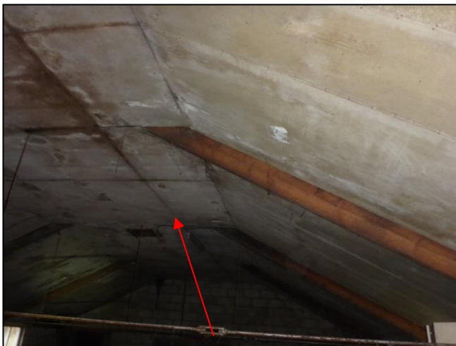
Foto 3: Schuur 1: Plafondbeplating (M01AA)
