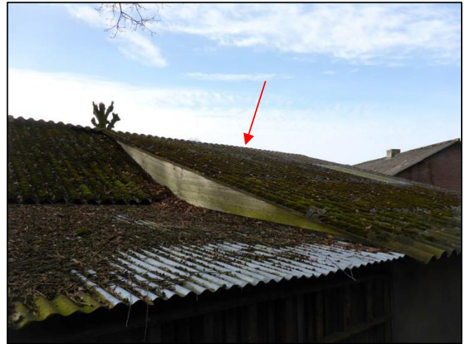
Foto 26: Schuur 4: Golfplaten dak (M05AA) (Gedeelte blikken platen)
