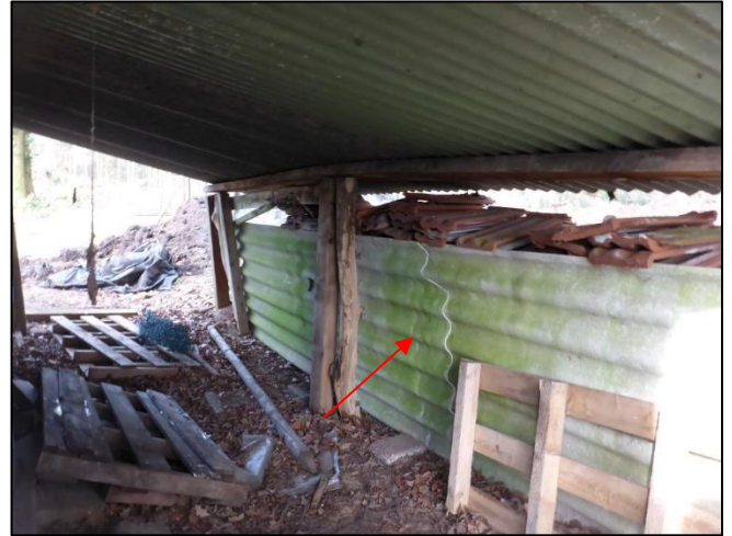
Foto 32: Achterzijde schuur 5: Golfplaat (M06AZ)
