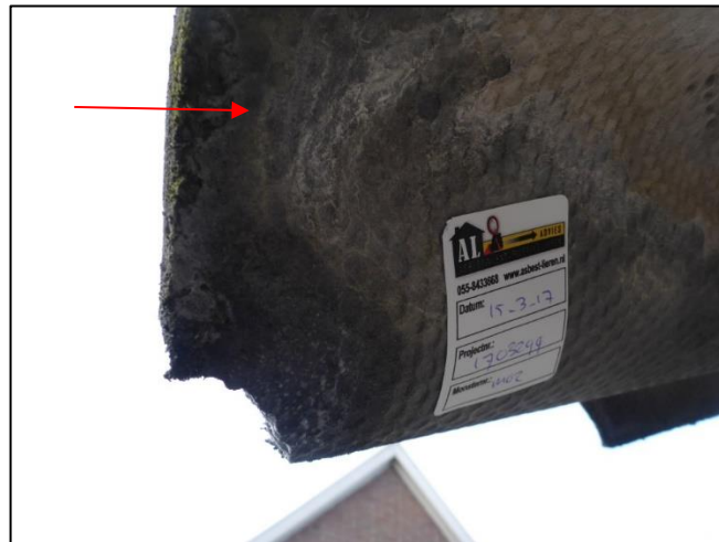
Foto 8: Schuur 1: Golfplaten dak (M02AA)
