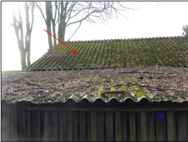
Foto 25: Schuur 4: Golfplaten dak (M05AA)
