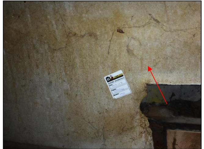
Foto 2: Schuur 1: Plafondbeplating (M01AA)
