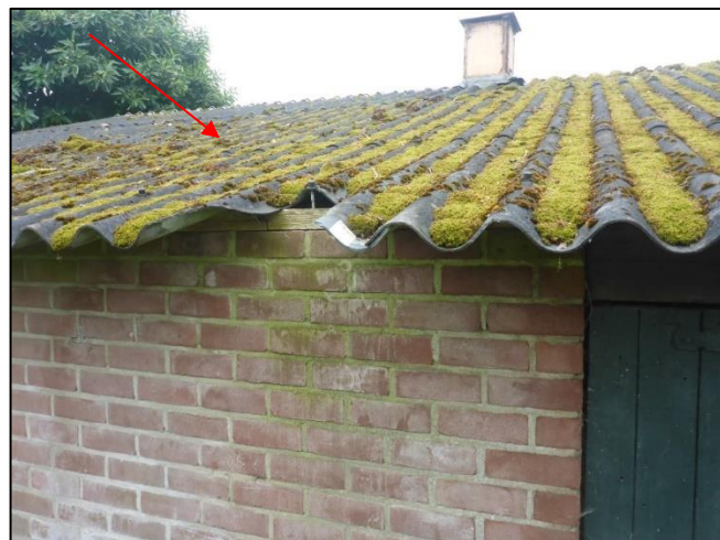
Foto 6: : Schuur: Golfplaten dak (M01AA)
