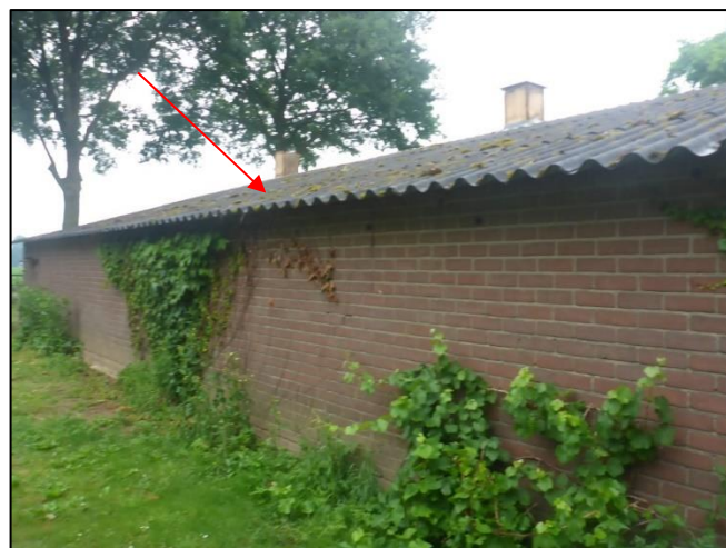
Foto 4: Schuur: Golfplaten dak (M01AA)
