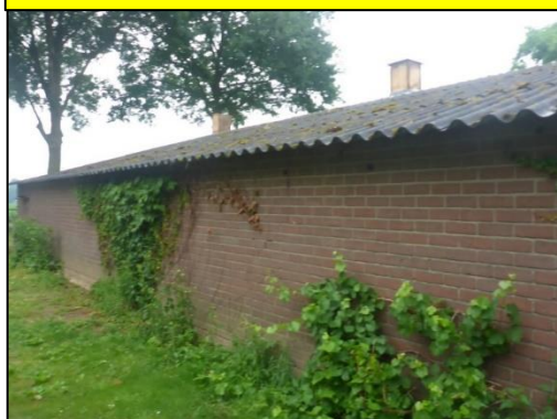
Schuur: Golfplaten dak (M01AA)
