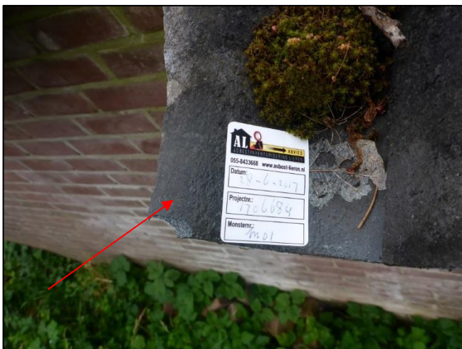
Foto 5: : Schuur: Golfplaten dak (M01AA)
