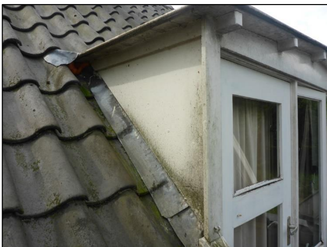
Foto 3: Dakkapel: Zijwang (Asbestvrij)
