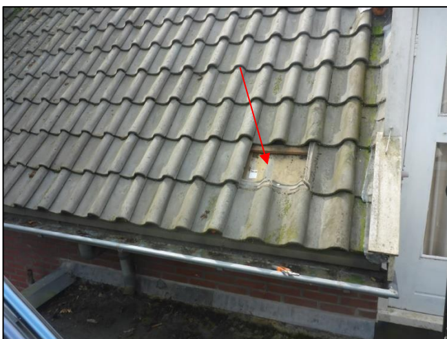
Foto 5: Woning: Dakbeschot (M01AA)
