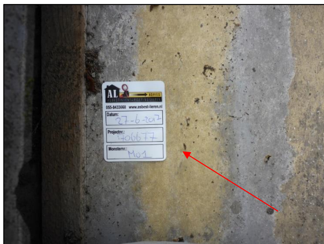
Foto 4: Woning: Dakbeschot (M01AA)
