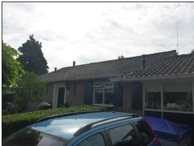
Foto 1: Woning, Piersonstraat 2 te Zelhem
