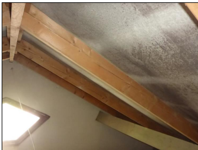
Foto 7: Woning: Dakbeschothout (M01AA)
