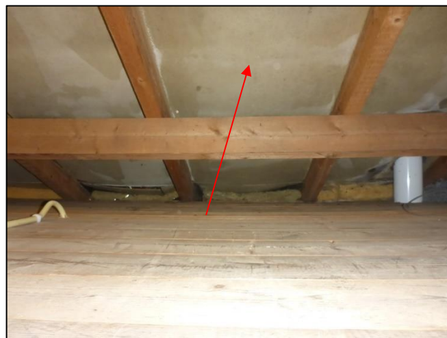
Foto 8: Woning: Dakbeschothout (M01AA)
