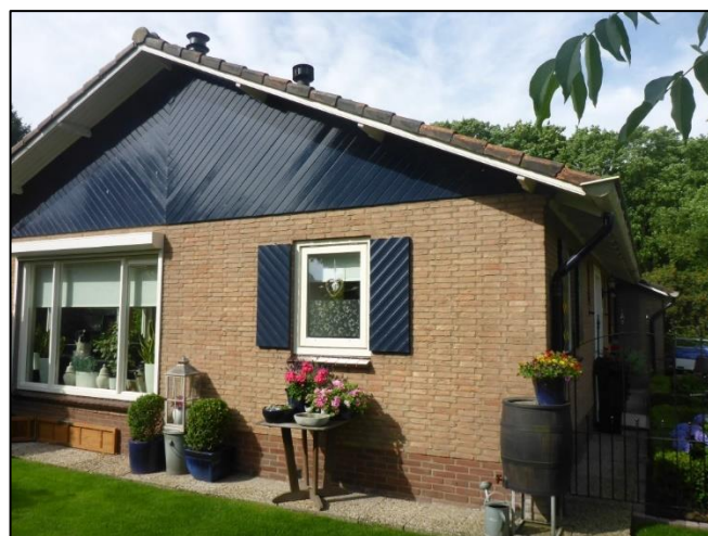
Foto 12: Aftimmering gevel: Hout
