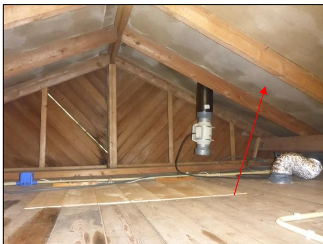
Foto 9: Woning: Dakbeschothout (M01AA)
