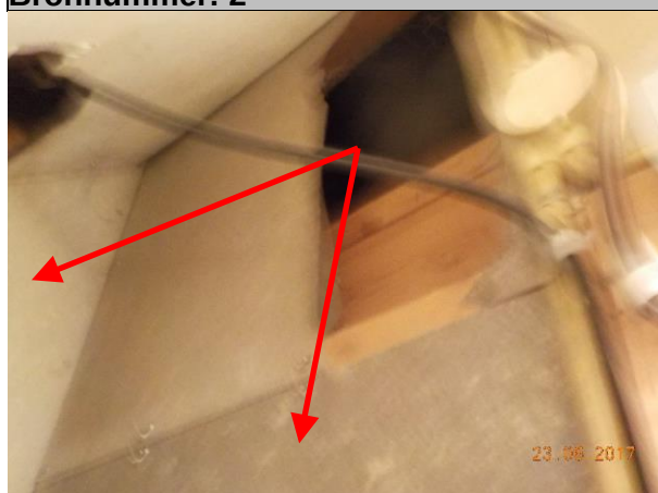
Vlakke platen aan wanden van cv-ruimte (binnen en gedeeltelijk buitenzijde)
